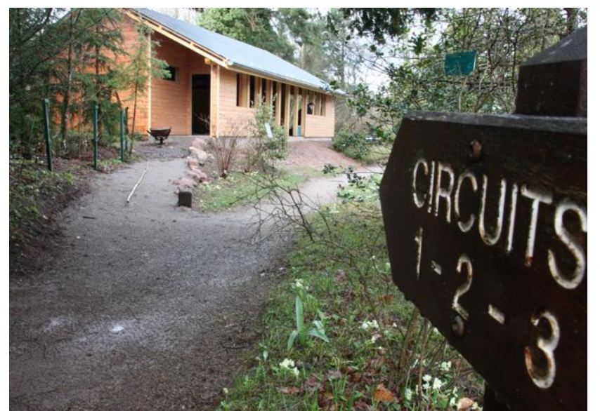
Les conférences et diverses autres animations auront lieu dans le pavillon du jardin dont les travaux d'agrandissement sont en cours de finition.
